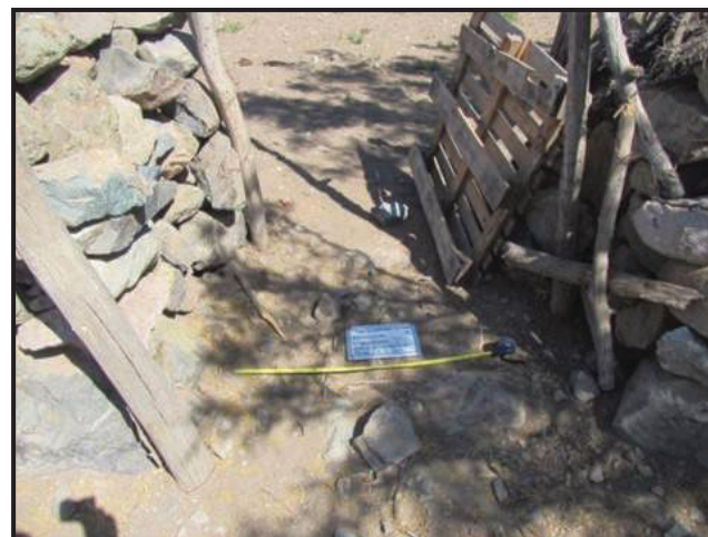
Figura 31. Cimientos de antiguo muro y apertura de vano. Corral de Ramadillas. Fuente: Elaboración propia.
