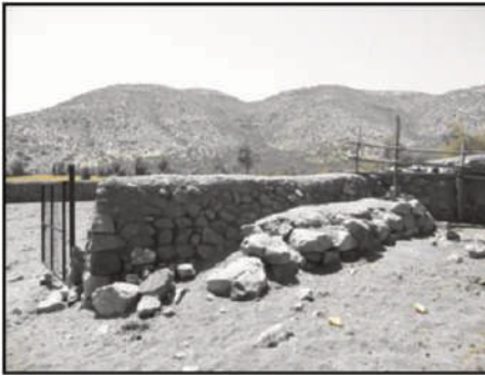
Figura 55. Estructura E2. Banqueta. Fuente: Elaboración propia.
