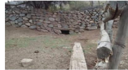
Muros de pirca de piedra.
