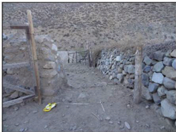
Figura 16. Estructura 3-Muro 2. Modificación M2: Apertura de vano y aplicación de revestimiento. Chalaco. Elaboración propia (Pavlovic et al. 2015).
