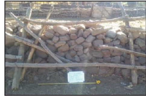
Figura 80. Estructura 1, muro 4. Cerca de contención Fuente: Elaboración propia.
