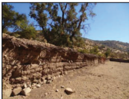
Figura 66. Estructura 1, Muro 5. Muro de tapial. Fuente: Elaboración propia.
