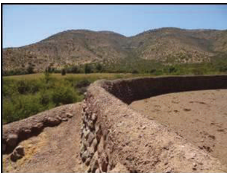
Figura 50. Estructura E1, Muro 1. Detalle mortero. Fuente: Elaboración propia
