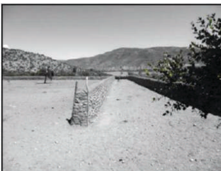
Figura 51. Estructura E2 y Pasillo. Fuente: Elaboración propia
