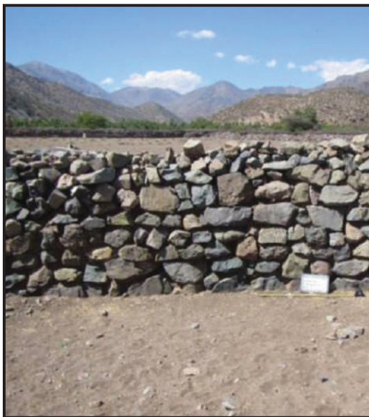
Figura 27. Vista Norte Muro 1, Estructura 2. Aparejo Sedimentario. Corral de Ramadillas. Fuente: Elaboración propia.
