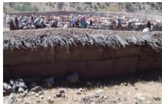
Detalle de los dos tipos de muros: pirca de piedra y tapial
