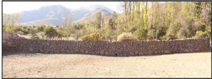
Figura 77. Estructura 1, Muro 1. Fuente: Elaboración propia.
