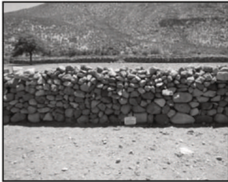
Figura 38. Estructura E1, Muro 1. Fuente: Elaboración propia.
