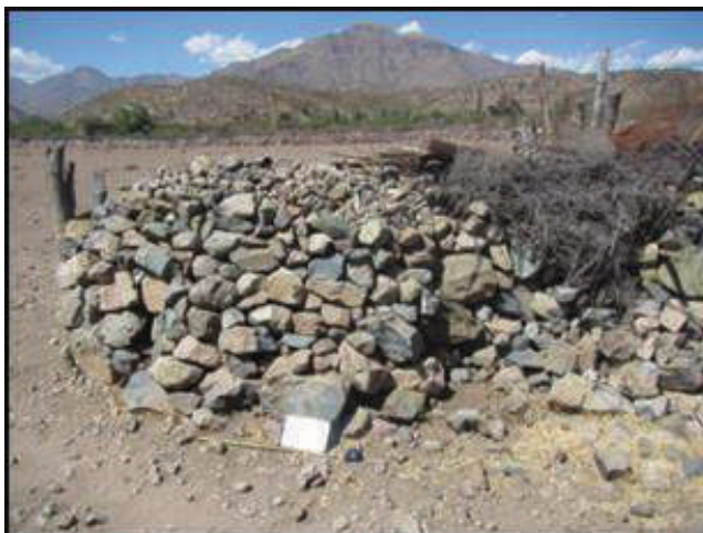
Figura 30. Muro de contención en Estructura. Corral de Ramadillas. Fuente: Elaboración propia.
