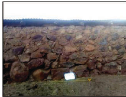
Figura 79. Estructura 5, Muro 3. Fuente: Elaboración propia.
