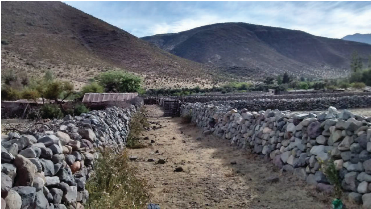
Figura 93. Vista de los corrales desde el pasillo lateral. Al costado oriente una de las viviendas que están en uso. Fotografía: Paula Ahumada Figueroa.
