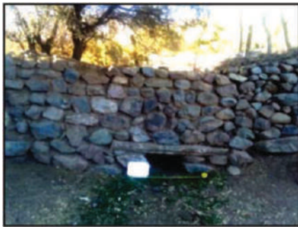
Figura 78. Estructura 4, abertura evacuación aguas lluvia. Fuente: Elaboración propia.
