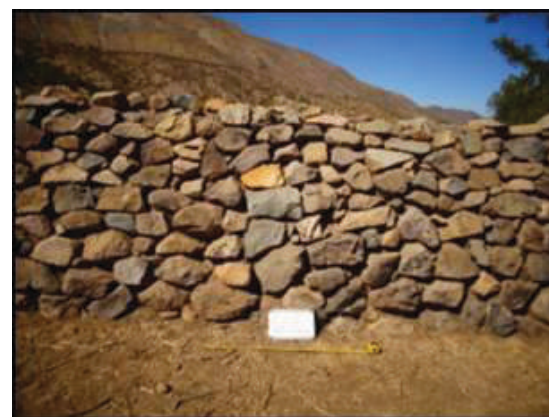
Figura 62. Estructura 3, Muro 3. Muro de tapial. Fuente: Elaboración propia.
