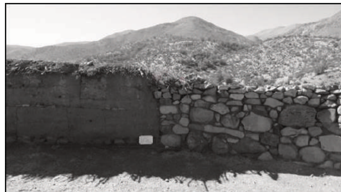
Figura 64. Estructura 2, Muro 1 y Muro 2. Relación de Capas estratigráficas de tapial y Capa D. Fuente: Elaboración propia.
