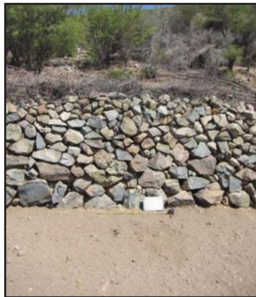
Figura 28. Vista Este Muro 1, Estructura 2. Aparejo Rústico. Corral de Ramadillas. Fuente: Elaboración propia.
