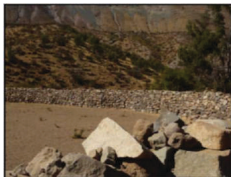
Figura 65. Estructura 2, Muro 2. Muro de piedra. Fuente: Elaboración propia
